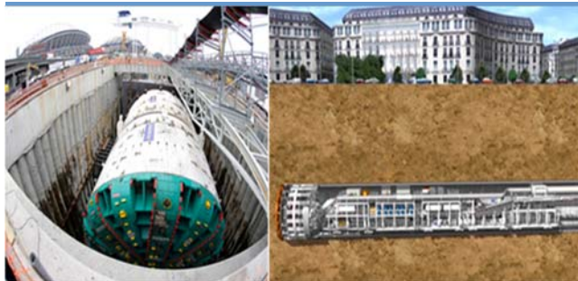
Figura 1. Tunnel Boring Machine (TBM) utilizzata nelle operazioni di scavo in sotterraneo per la realizzazione di grandi opere ingegneristiche.
